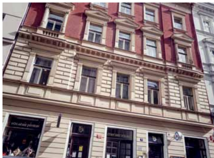
Průčelí a vnitroblok budovy v Křemencově ulici v dnešní době
