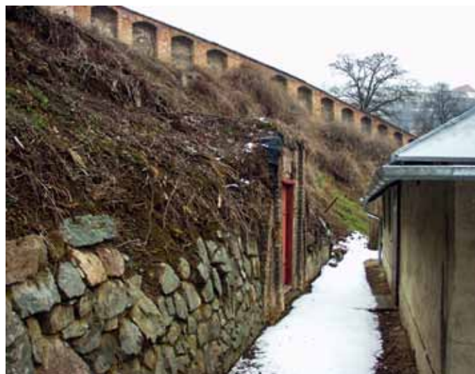
Po úpravách, zima 2003. Později se musela obnovit kamenná zeď
